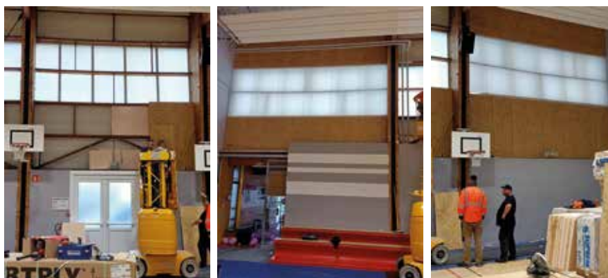
Travaux d'isolation au COSEC
