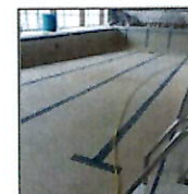
Travaux de maintenance de la piscine réalisés en interne et en collaboration avec des entreprises spécialisées.
