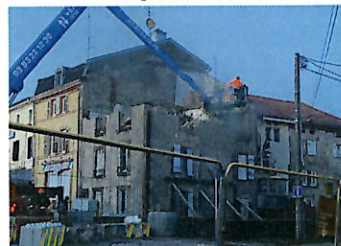
La démolition de la maison sur la place des Vosges se déroule sans encombre. La place sera à nouveau accessible très bientôt !
