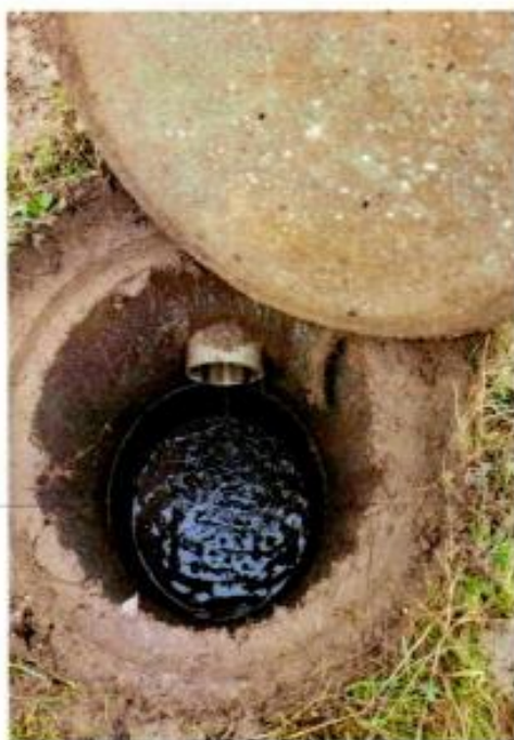
Photo 4: en contrebas du point 30 et nettement visible se trouve un regard sur la conduite d'eau usée, nettement visible ...
